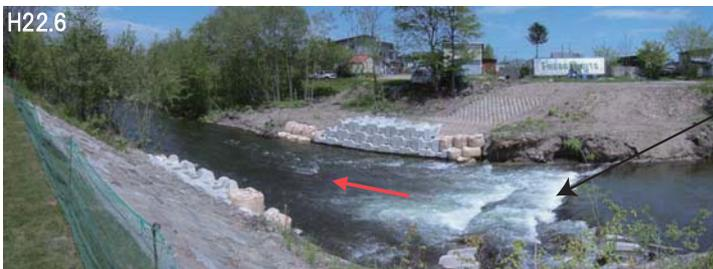
白い泡立ちは、上水道管横断部の露出箇所に袋材と根固めブロックで応急対策を実施した箇所
