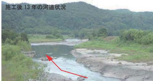
・ショートカットにより洪水被害は軽減されたが、河川を急変させたことで河床低下が起こり、現在は上流側まで作用している。
