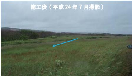
・平均年最大流量時水位以上の掘削とし、水際植生、低水路、河床を保全した。
