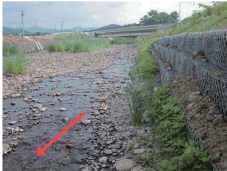
・ 平成24年度施工箇所において、護岸工を施工した2箇所の内1箇所では寄石が流出した。勾配が1/60と急であるため、融雪出水時に流出したものと考えられる。
