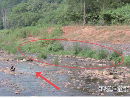
・ 寄石工は未施工だが、植生が回復し礫が自然に堆積してきている。
