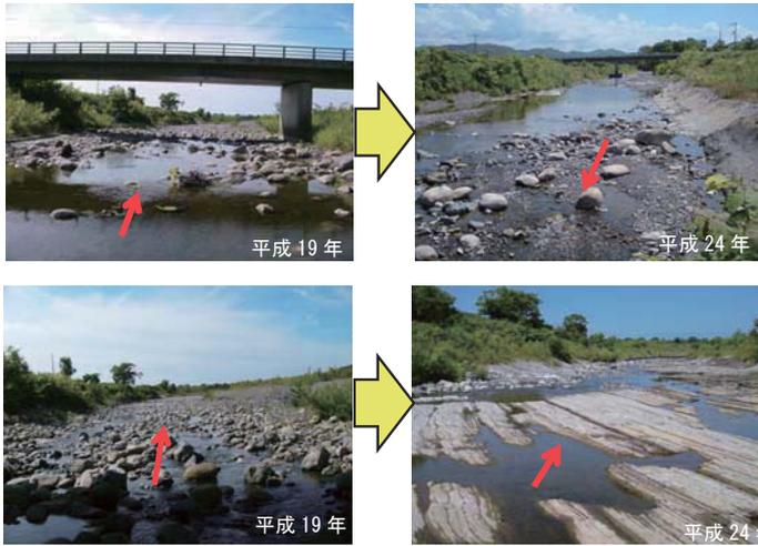
・現地調査の結果、著しく河床低下を起こしており、平成19年に比べ、護岸基礎部の根入れ不足など構造物への影響が懸念されることが確認された。
