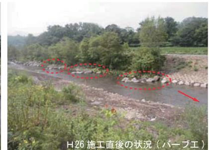
・現地発生巨石をバープ工法を参考に配置し、護岸根元部における土砂捕捉効果を期待。
