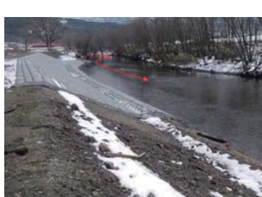
宇曽丹橋より上流の 施工後の河道状況（H27）
