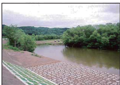
ワンド整備後の状況（H14撮影）
