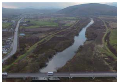
施工前（滞筋が固定化され単調な川相）
