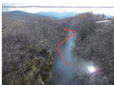
宇曽丹橋より上流の 施工前の河道状況（H19）
