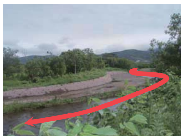
河畔林等に配慮した河岸掘削状況
