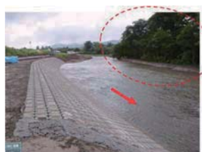
施工直後（平成 21 年 8 月）
