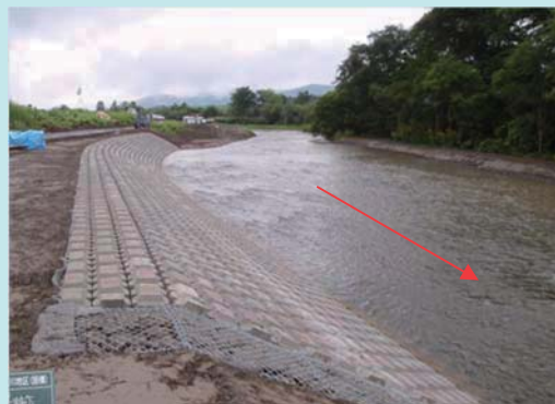
施工直後（平成21年8月）
