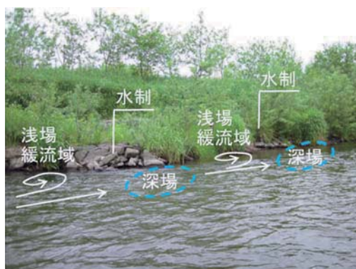
石を利用した水制工（標津川）
