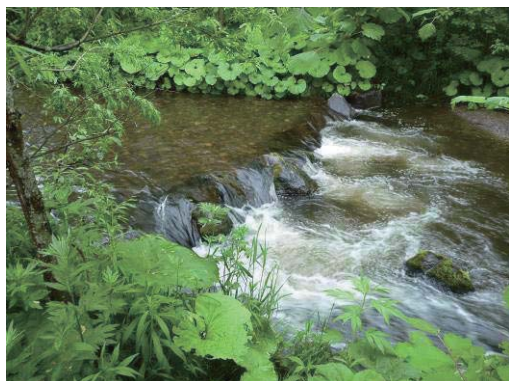
巨石を用いた帯工（厚別川）
