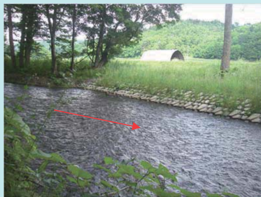
施工2年後の様子（平成22年7月）
