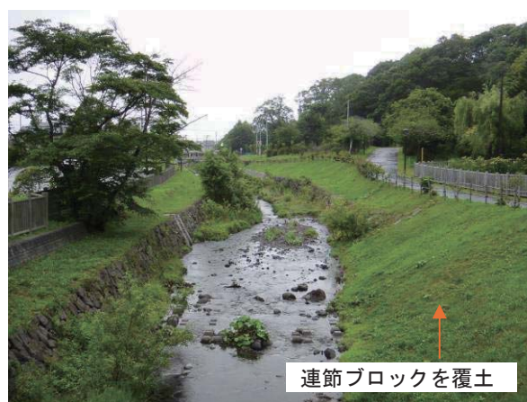
被覆による隠し護岸（西富岸川）
