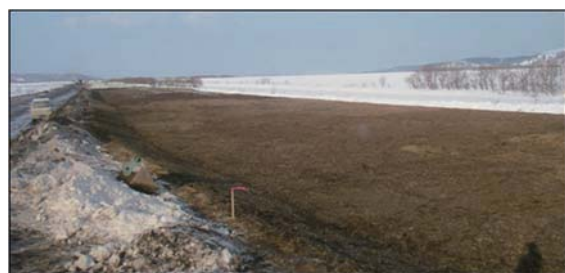
H23. 3. 30（施工直後）
