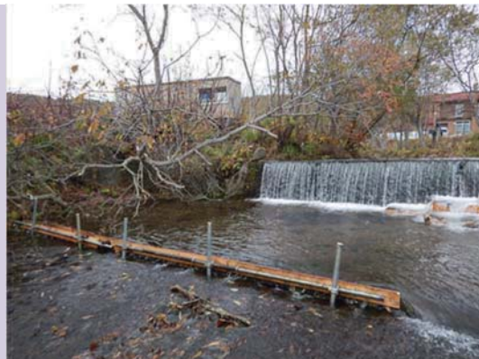
水叩き水深のせき上げ(H27. 10. 27)
