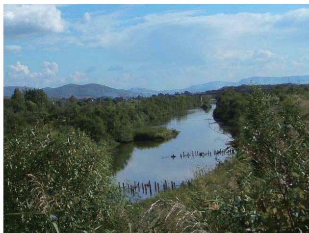
木杭を設置した例（剣淵川）
