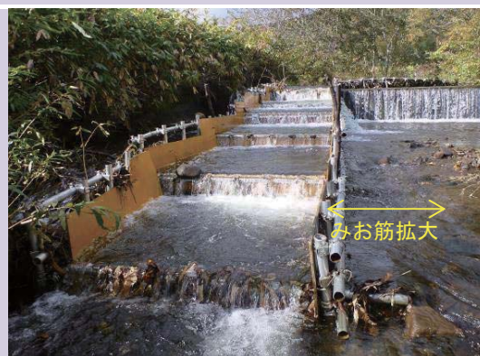
隔壁部への板設置後 (H27. 10. 13)
