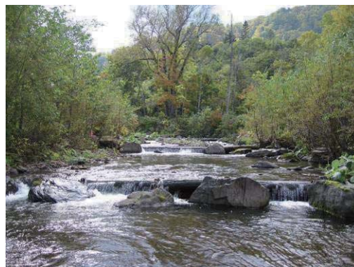
巨石・倒流木を用いた帯工 15) （幌内川支流パンケオロピリカイ川）
