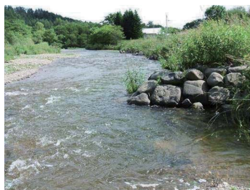
石を利用した水制工（居辺川）
