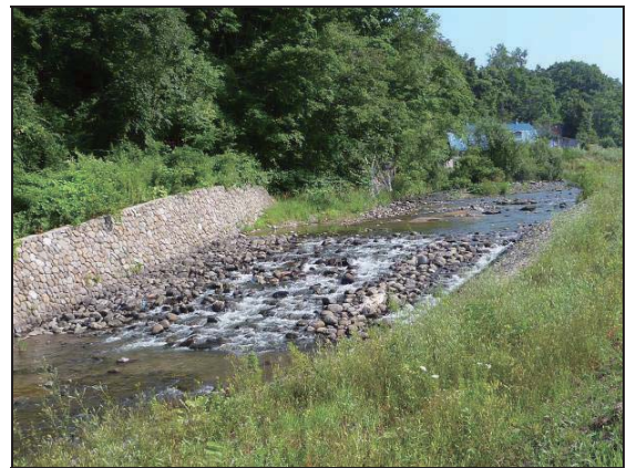
ステップ&プールとなっていない斜路工
