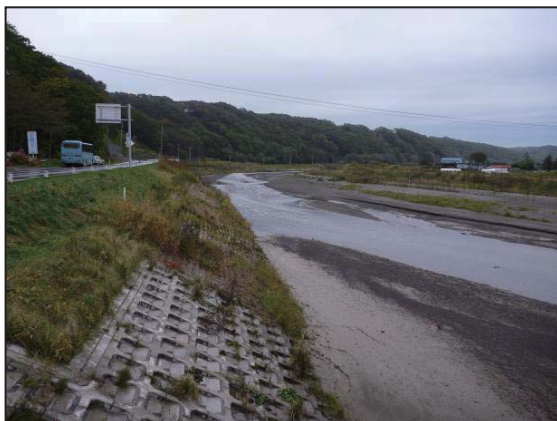
幾千世橋周辺の状況
