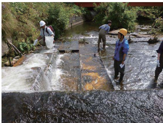
1号落差工魚道
