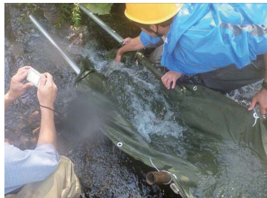
3号落差工魚道 入口部の様子
