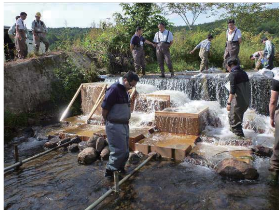
2号落差工魚道
