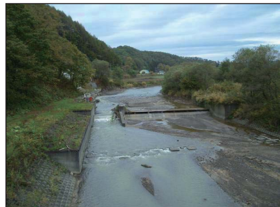
頭首工の状況
