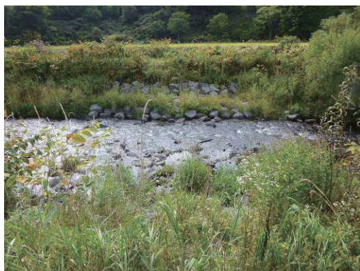
河床低下対策区間（自然石帯工）
