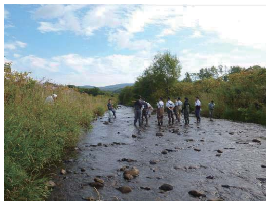
河床低下対策区間の様子
