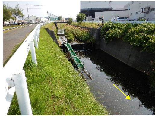
2号床止への布式魚道設置
