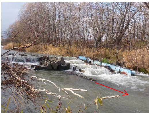
魚道設置 1 年後状況
