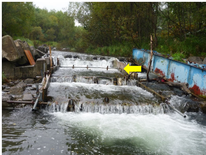
最上段の隔壁（矢印）は、落差工からの落水・跳水により流下物の捕捉が見られなかったため、板張りを設置しました。
