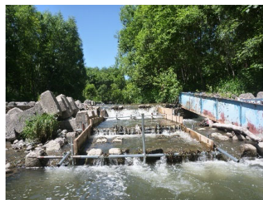
「突出し型 単管枠組み魚道」の概況
