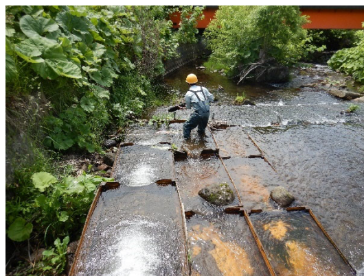
魚道内のゴミ除去作業
