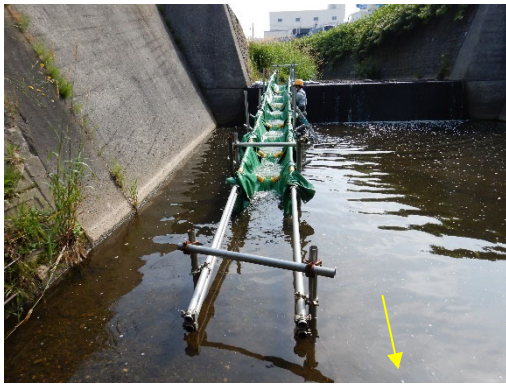
1号床止への布式魚道設置
