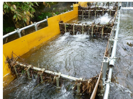
流下物捕捉による隔壁の例
