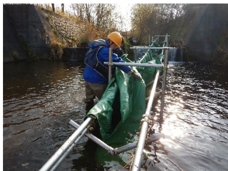
撤去作業（シートのみ）
