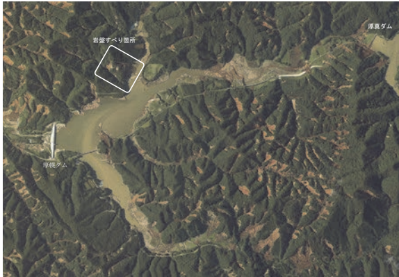
図 3-9 厚幌ダム貯水地の周辺の斜面崩壊状況 参考文献 5
