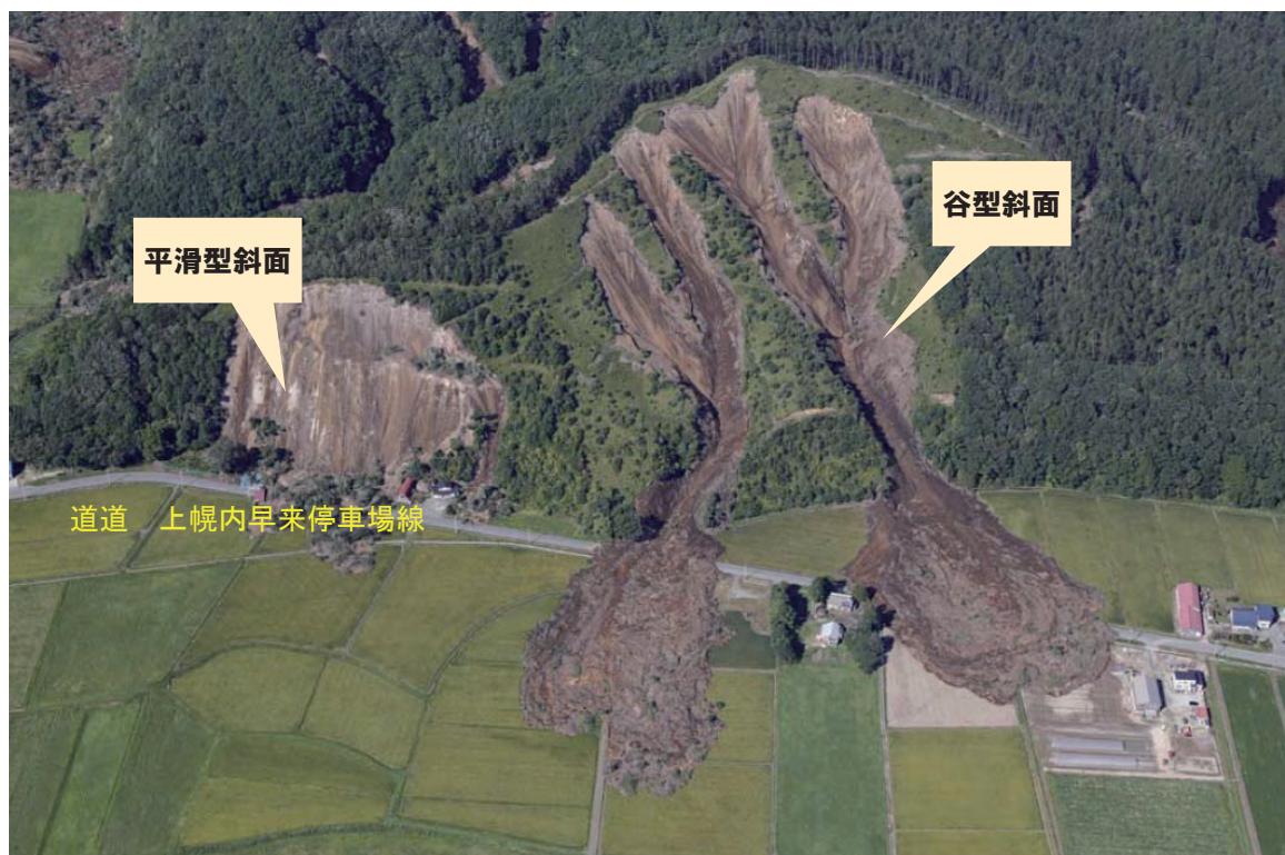
写真3-1 厚真町幌内地区の斜面崩壊
