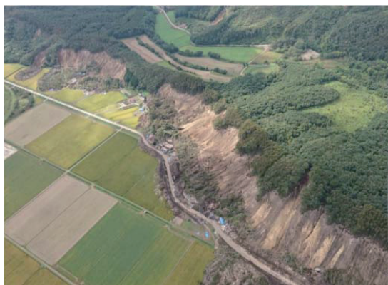
写真 3-3 吉野地区の斜面崩壊の状況図 出典：参考文献 1
