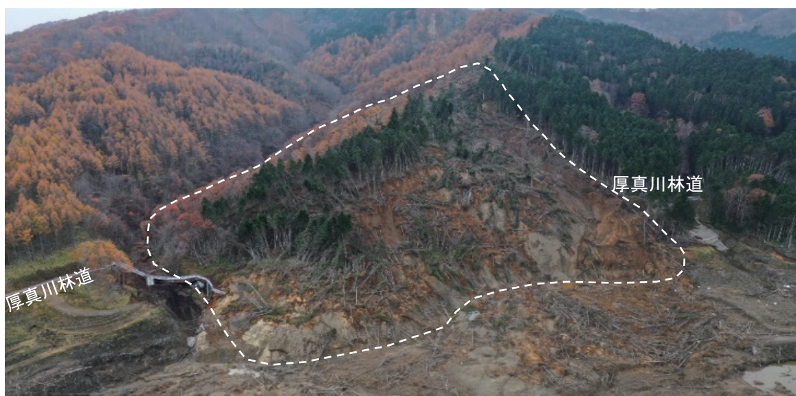
写真3-2 厚幌ダムの岩盤すべり
