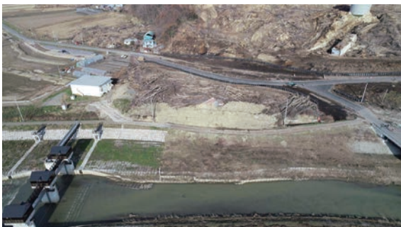
写真8 厚真町富里地区の厚真川流入土砂の除去完了
