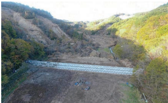
写真2 メナの沢川ブロック堰堤（応急工事）
