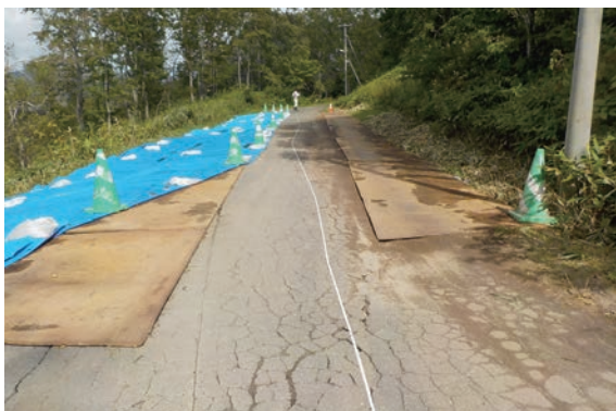
写真4 生田3線応急対応（敷鉄板+シート保護）
