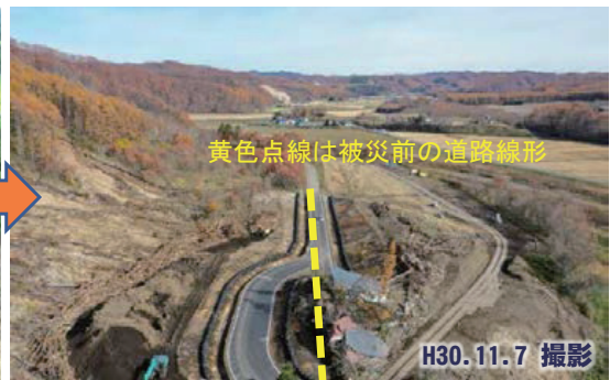
写真 29 仮設道路により被災家屋を迂回し通行を確保
