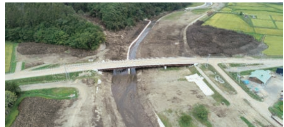
写真6 厚真川幌内地区の土砂除去完了
