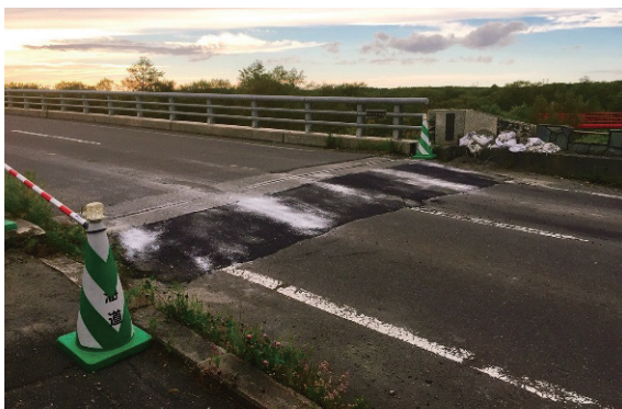
写真18 豊川遠浅停車場線 豊川橋 橋台背面段差仮復旧作業
