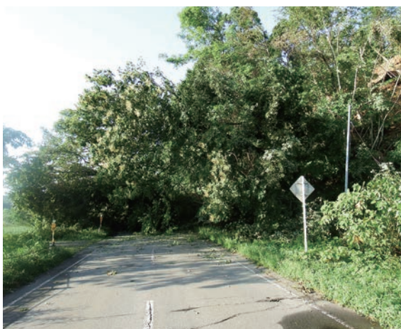
写真1 土砂崩れ発生状況
