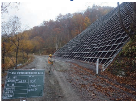
写真7 栄豊田線災害復旧工事
