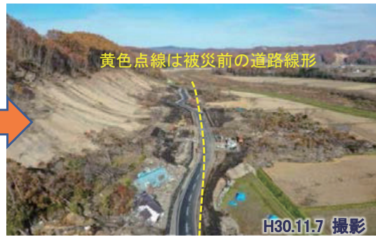
写真 25 仮設道路により通行を確保
