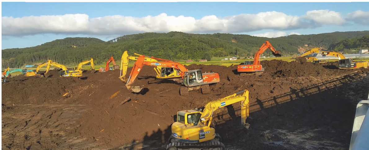
写真3 厚真川埋塞土砂除去作業 バックホウ約80台による土砂除去作業状況
