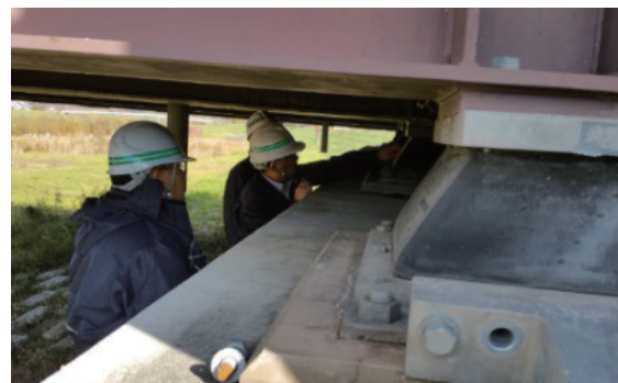
写真10 千歳鷗川線 厚真大橋 橋梁点検状況
