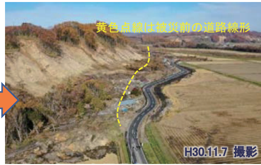
写真 23 仮設道路により通行を確保
