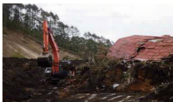
写真13 上幌内早来停車場線 厚真町吉野地区 道路上の家屋を迂回しながらの道路啓開作業
