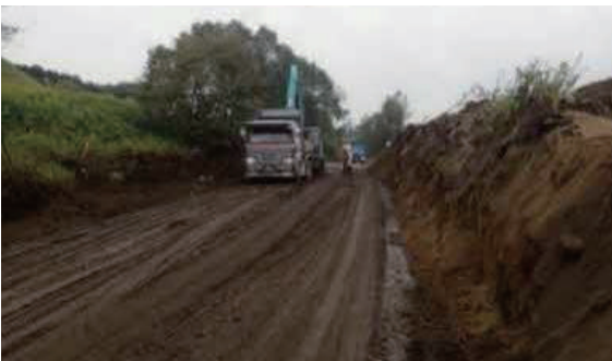
写真15 千歳鷗川線 安平町早来北進地区 緩勾配での崩土除去作業
