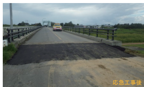
写真34 厚真浜厚真停車場線 上厚真大橋 車道応急復旧状況
