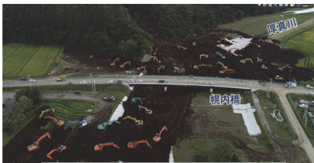
写真1 被災直後の埋塞土砂除去作業
