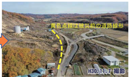
写真 27 仮設道路により通行を確保
