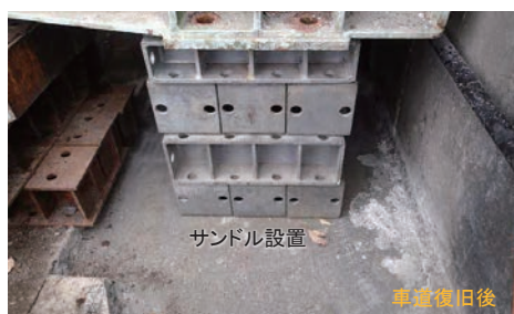
写真33 厚真浜厚真停車場線 上厚真大橋 応急復旧状況（サンドル設置）
