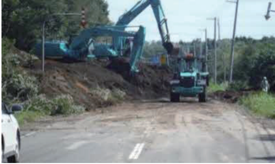
写真14 千歳鷗川線 安平町早来北進地区 含水比の高い崩土除去作業
