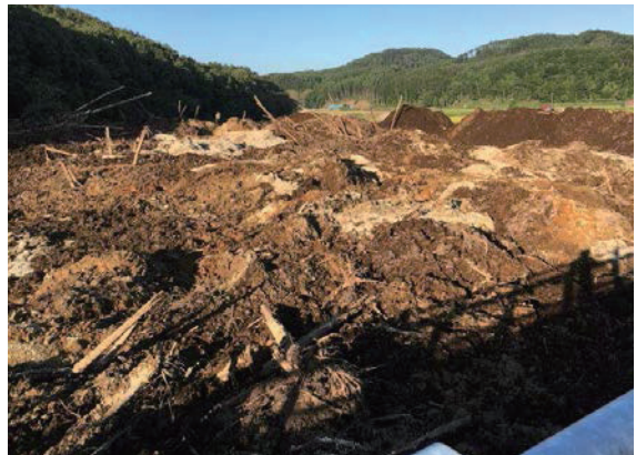
写真3 厚真川河道閉塞状況（道道上幌内橋上流）6：00
