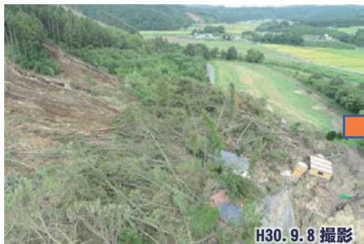
写真 28 大量の崩土により道路が埋没
