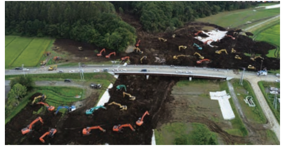
写真5 厚真川幌内地区の土砂除去作業
