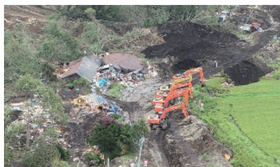
写真12 上幌内早来停車場線 厚真町吉野地区 舗装面を確認しながらの道路啓開作業
