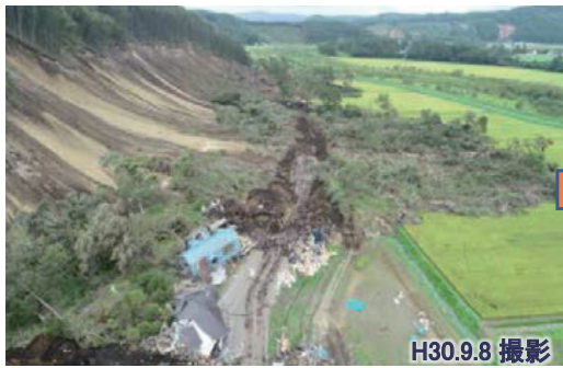
写真 24 大量の崩土により道路が埋没
