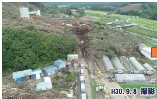
写真 26 大量の崩土により道路が埋没
