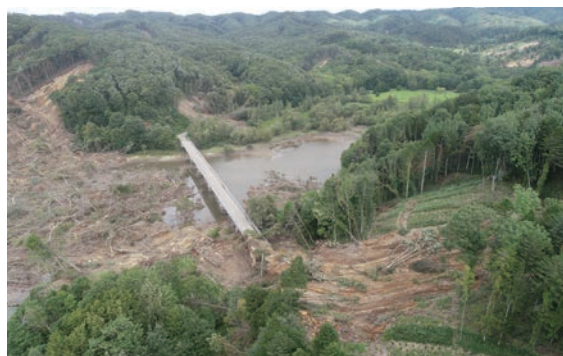
写真3 瑞穂林道2号線被災状況（ドローン調査）
