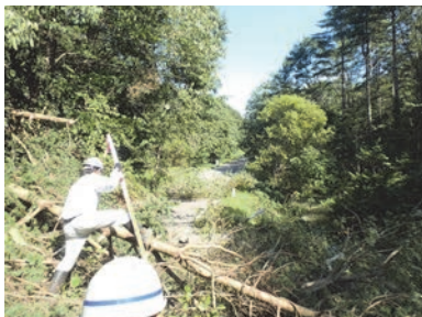
写真2 初動調査の作業状況
