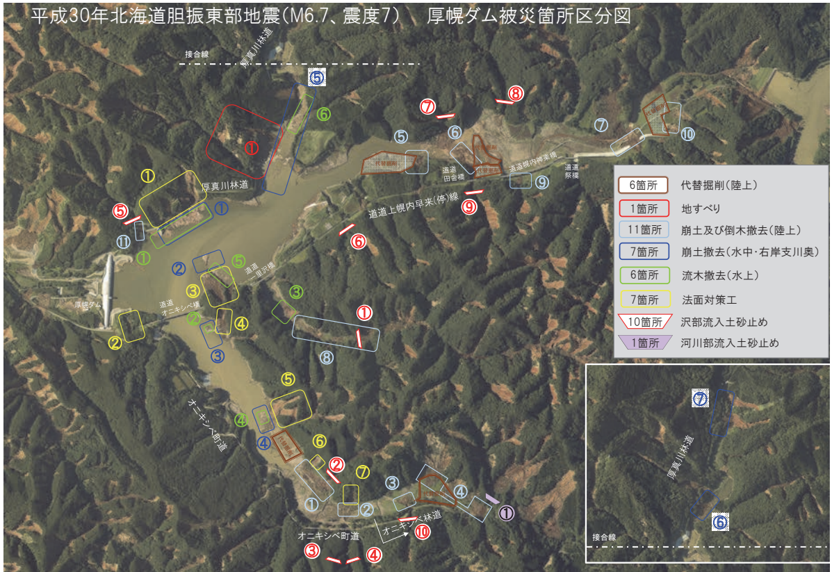
図2 厚幌ダム被災区分図 国土地理院「平成30年(2018年)北海道胆振東部地震に関する情報」の公開写真を使用し作成
