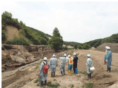
写真1 初動調査の作業状況
