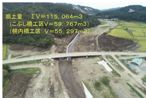
写真2 H30.12.3 土砂除去完了状況
