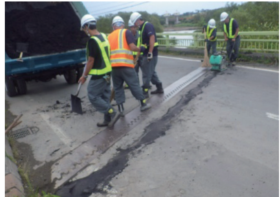
写真4 厚真浜厚真停車場線 若草橋 橋台背面段差仮復旧作業
