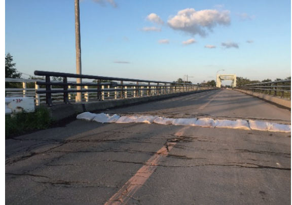
写真3 厚真浜厚真停車場線 上厚真大橋 橋台背面段差の応急対応状況
