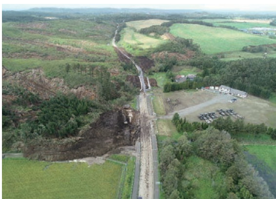
写真6 千歳鷗川線 厚真町本郷地区 9月8日撮影 道路啓開作業確認
