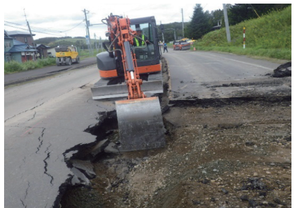
写真17 平取厚真線 厚真町宇隆地区 路面段差仮復旧作業
