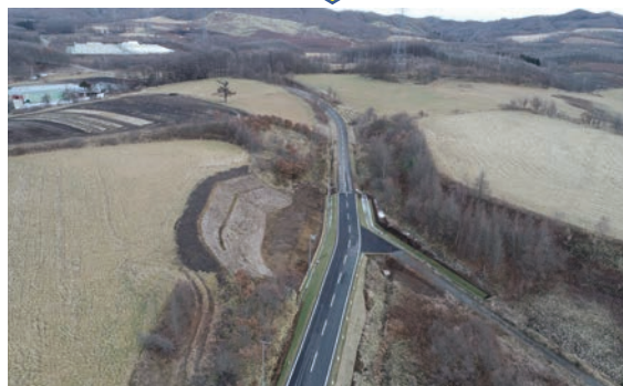
写真8 守田開拓線の復旧状況
