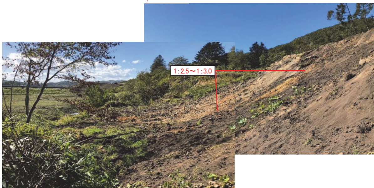
写真1 厚真町富里地区の崩土の堆積状況
