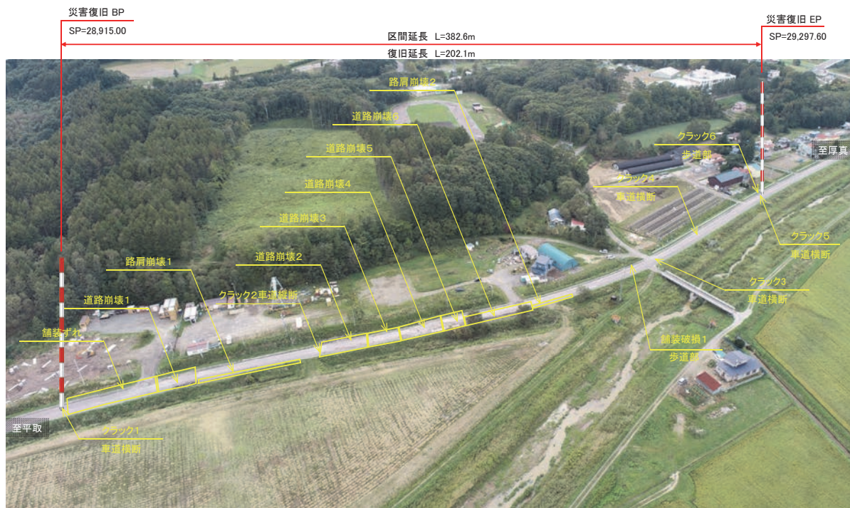
全景 SP=28,915.00～29,297.60（区間延長 L=382.6m、復旧延長 L=202.1m）（H30.9.8撮影）
