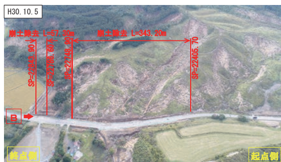
崩土除去後（H30.10.5 撮影）
