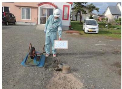
L7 汚水柵浮上地盤沈下
