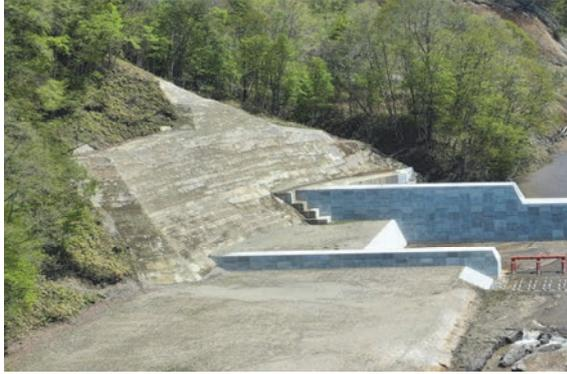
写真6 砂防ソイルセメントによる法覆工 (シュルク沢川)
