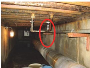
エア抜き配管漏水状況
