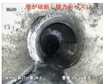
管の破断によるズレ
