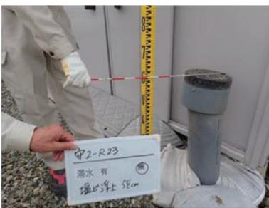
汚水柵浮上地盤沈下
