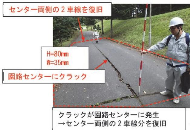
2車線分を復旧した際の被災状況
