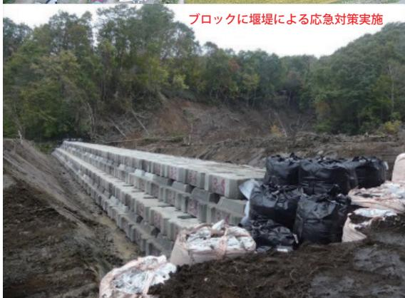
写真2 応急対策の状況 吉野北1の沢 (砂防)
