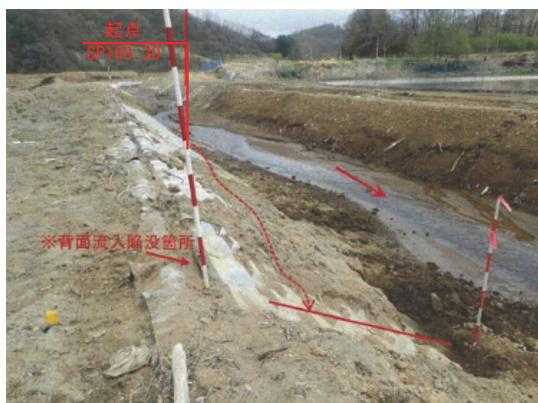
令和 2 年 3 月被災状況 SP169.30 ブロック波状沈下
