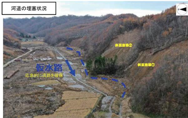
写真2 河道の埋塞状況
