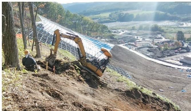
斜面土砂掘削作業 (断崖掘削機使用)
