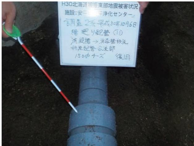
完成（沈殿槽→消毒槽移設） 移流配管合流部（H30.10.6 撮影）
