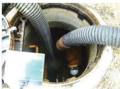
施工中（左：污泥吸引車による管内土砂吸引状況 右：雨水管埋設工）
