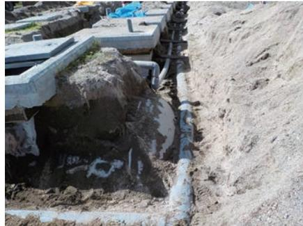
施工中（配管変形、分配槽浮上）（H30.9.29 撮影）
