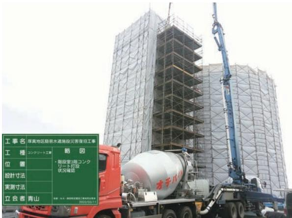
施工中（階段室コンクリート打設）
