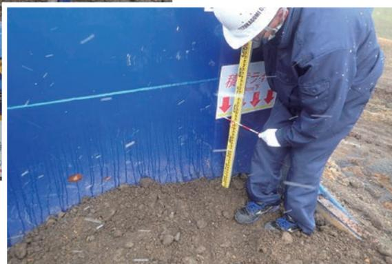
写真4 土砂の積載量管理
