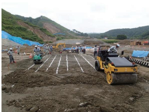
ソイルセメント試験施工の状況
