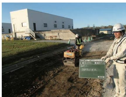
外構施工中（路床転圧状況）
