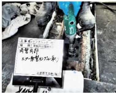
施工中 (エア抜き配管撤去)
