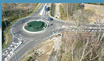
※道道きたひろしま総合運動公園線ラウンドアバウト
